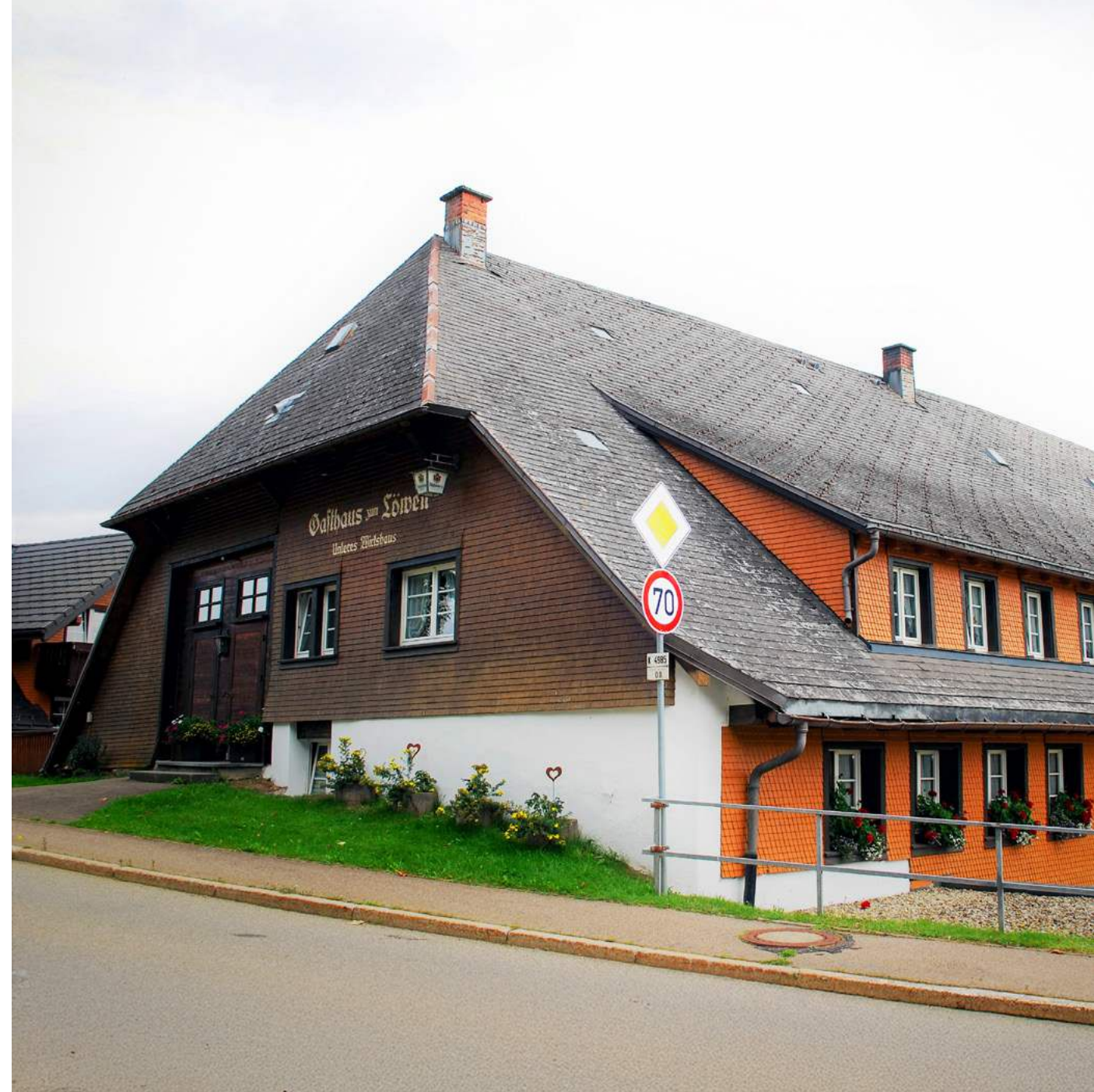
Das Gasthaus »Zum Löwen Unterer Wirtshaus« liegt direkt an der Straße durch das Langenordnachtal. Der ehemalige Ökonomieteil (zur Straße hin gelegen) weist noch die für Bauernhäuser typische Hofeinfahrt auf.
