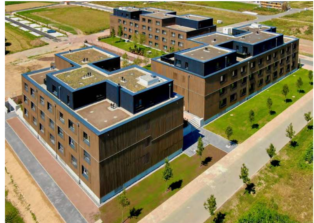
Auf dem Campus zwischen Freizeitpark und Wasserwelt wurden Unterkünfte für 280 Mitarbeitende geschaffen.
